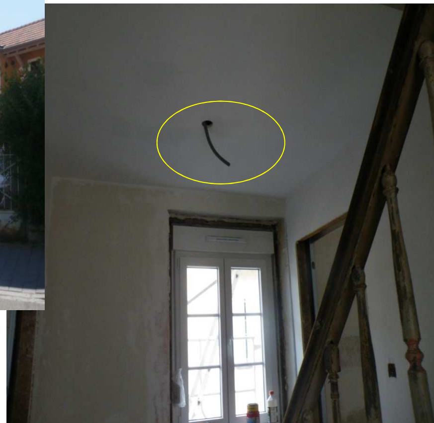
Mise aux normes électriques, remplacement des menuiseries
