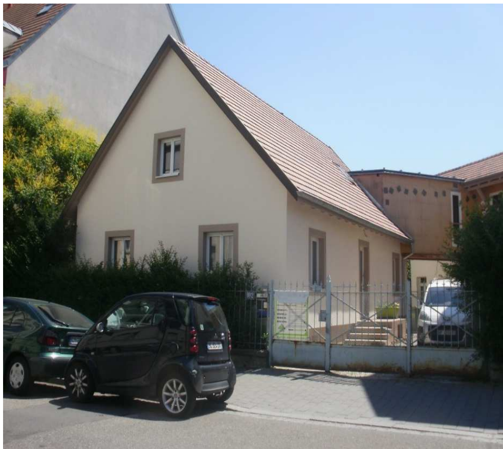
Isolation de l'extérieure et remplacement des menuiseries sur une maison individuelle
